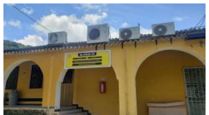
ASPECTO BLOQUE TRES
