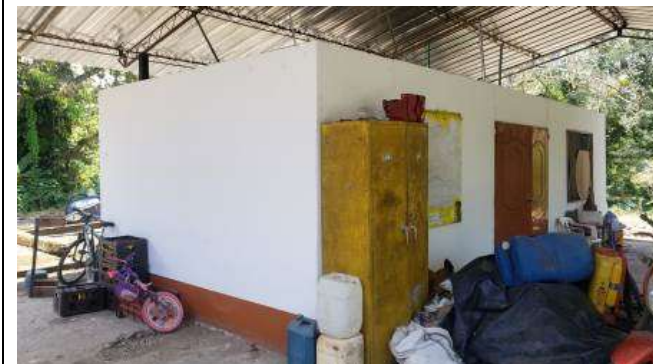
CONSTRUCCIÓN ESTRUCTURA METALICA
