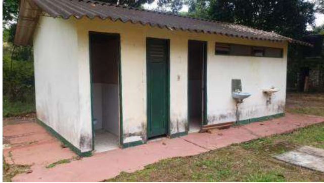
ASPECTO CONSTRUCCION No. 4
