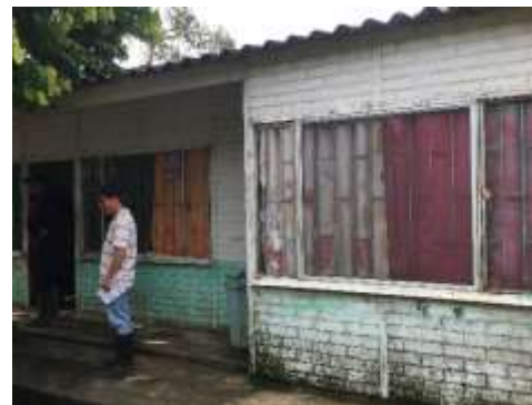
CONSTRUCCIÓN CASA ADMON
